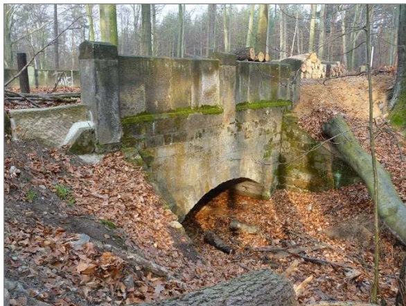
Gewölbte Brücke des PM-Wegs über den Eisenbornbach © M. Thieme, 2014
