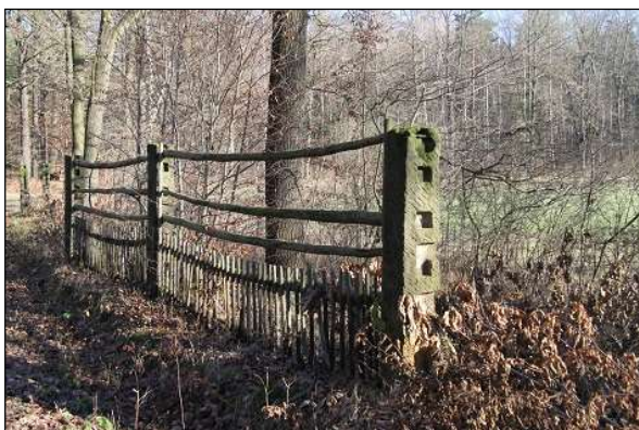
Reste der Umfriedung der Hofewiese am Kannenhenkel
