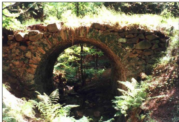
Die Hohe Brücke überführt den Nachtflügel über das Ullersdorfer Dorfwater
