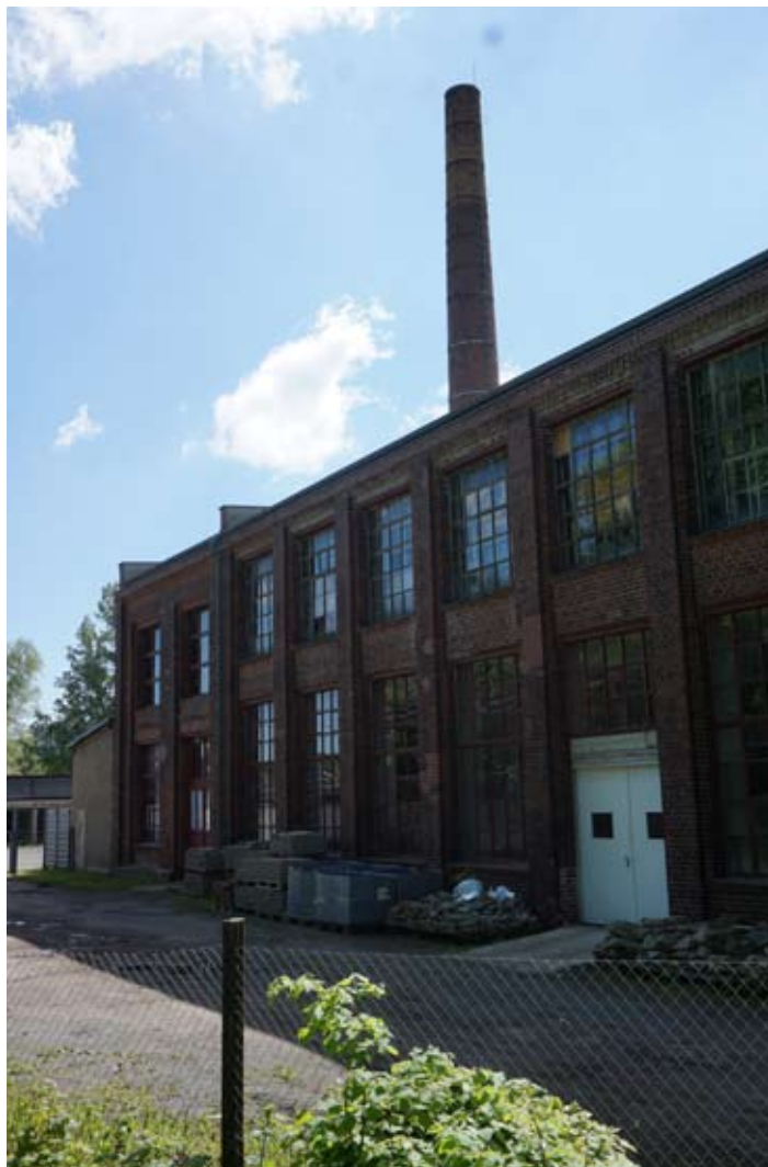
Bobinetspitzenweberei R. Kant KG. Im zweigeschossigen Fabrikgebäude, durch die Firma Zwickauer Spitzenweberei GmbH Artzt & Hempel errichtet, befindet sich noch heute ein denkmalgeschützter Maschinenpark mit Webstühlen der ehemaligen Spitzenweberei, teilweise noch funktionstüchtig
