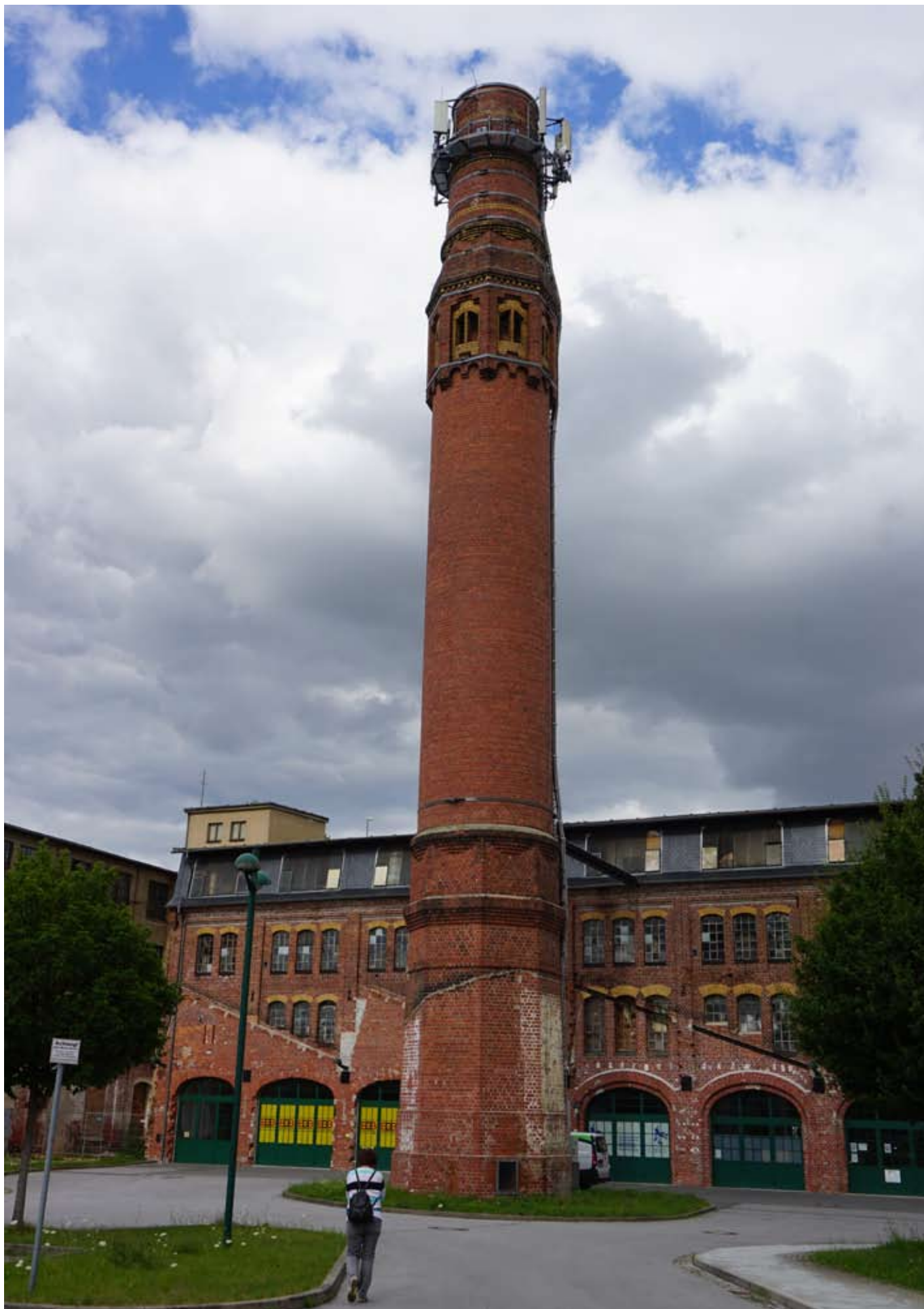
Frühere Schubertsche Fabrik in Zittau, ehemaliger Textilbetrieb, heute umgenutzter Standort unter dem Namen „Mandau Höfe“. Fotos Petra Westphalen.
