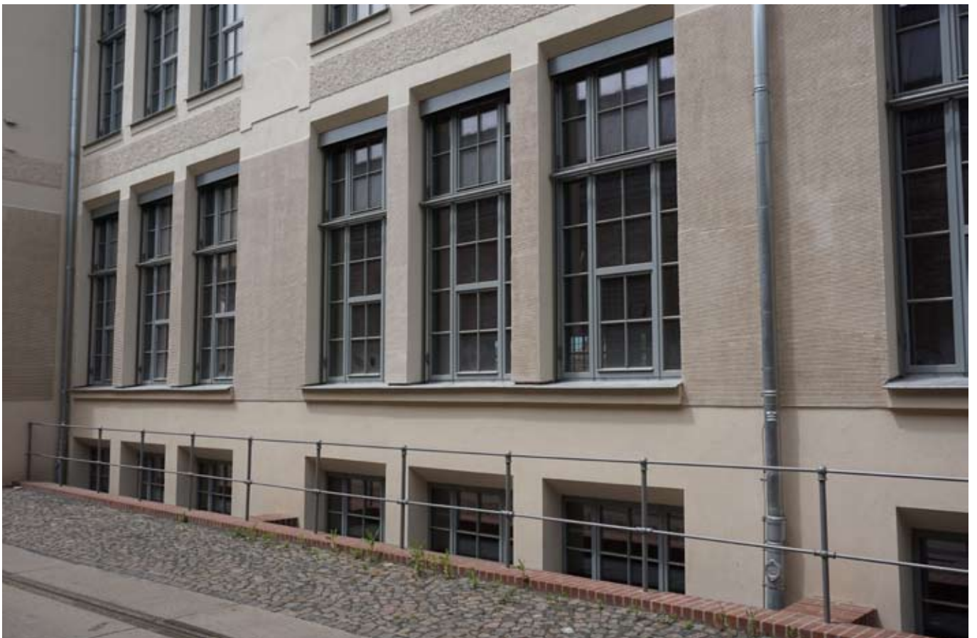
Vierte Spinnerei von 1906 mit horizontaler Putzrillenstruktur.
