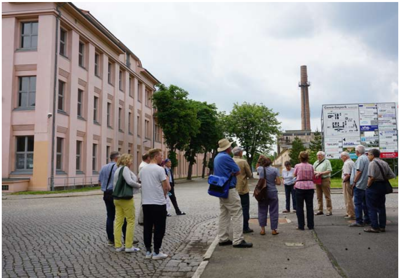
Teilsanierter Westflügel E-Gebäude (links). E entspricht dem Gebäudegrundriss. Fotos Petra Westphalen.
