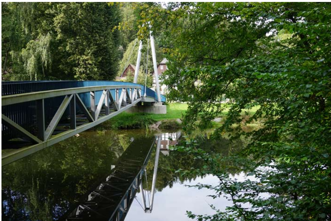
Hängebrücke über die Zwickauer Mulde. Foto Petra Westphalen.
